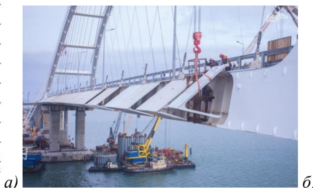
Рисунок 9 – а) зависимость амплитуды колебаний пролетного строения автодорожной арки Крымского моста от скорости ветра; б) монтаж разработанных обтекателей на автодорожную арку Крымского моста
